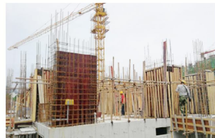
洁源城龙溪水岸工程
