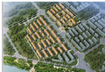
东至经济开发区安置房建设
